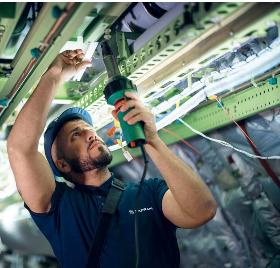
La cabine d'un Boeing 777 en pleine modification par un collaborateur Safran Electrical & Power.
